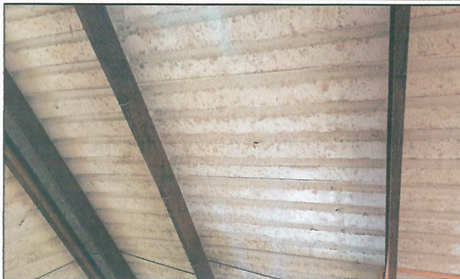
Foto 1: Mejoramiento cubierta de lamina
