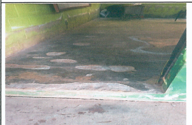
Foto 4: Mejoramiento de Piso
